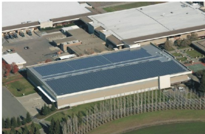
1.4. MW Voltaics array in Sonoma Valley
